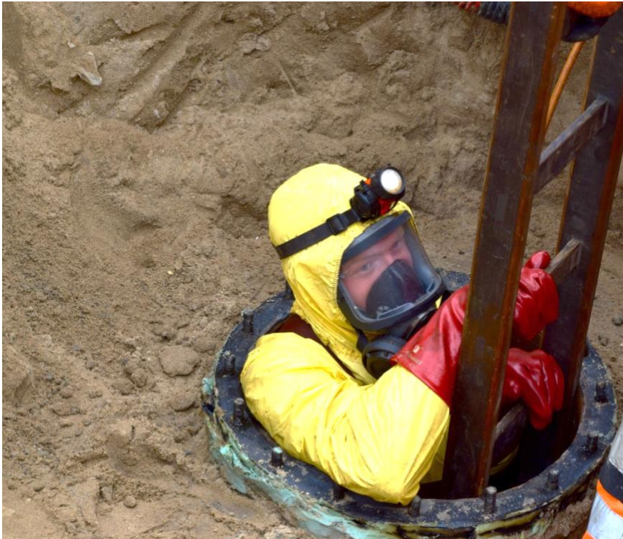
Foto 1: Het schoonmaken van de tank.
