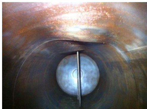
Foto 2: Vervorming tanklichaam.
