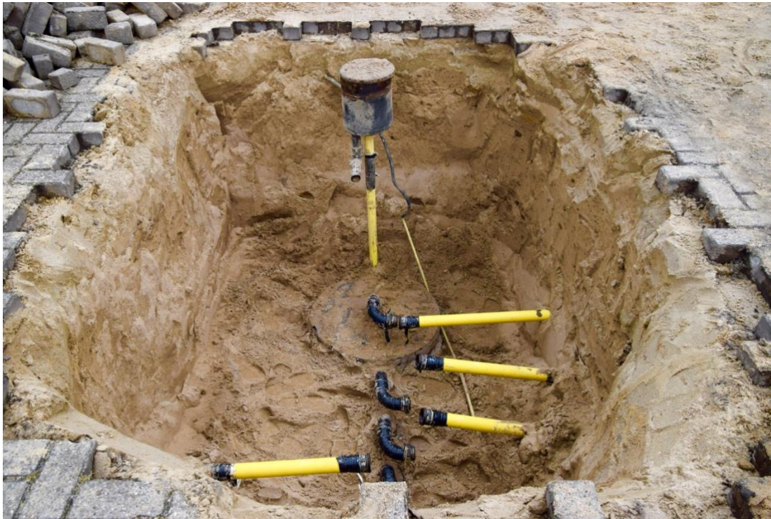
Foto 10: Controle van tank en leidingwerk.
